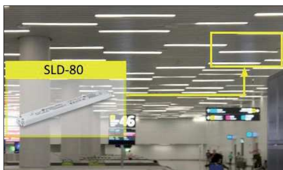
Obr. 3. Použití zdrojů SLD k osvětlení podzemních prostor
